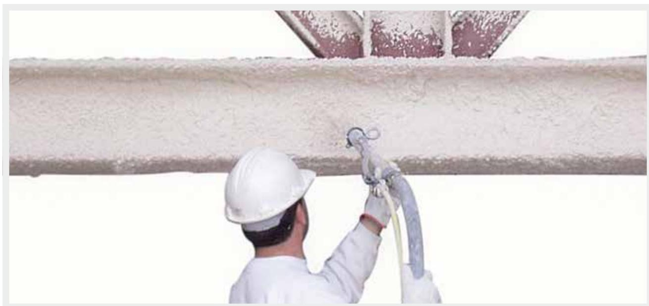
antincendio a base gesso con caratteristiche molto interessanti per i professionisti dell'antincendio, additivato con perlite e vermiculite per la protezione passiva dal fuoco, destinato all'applicazione su elementi strutturali interni.
