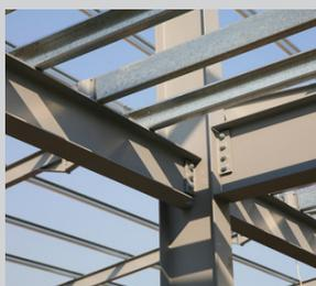
Struttura antisismica realizzata con elementi in acciaio zincato a caldo
